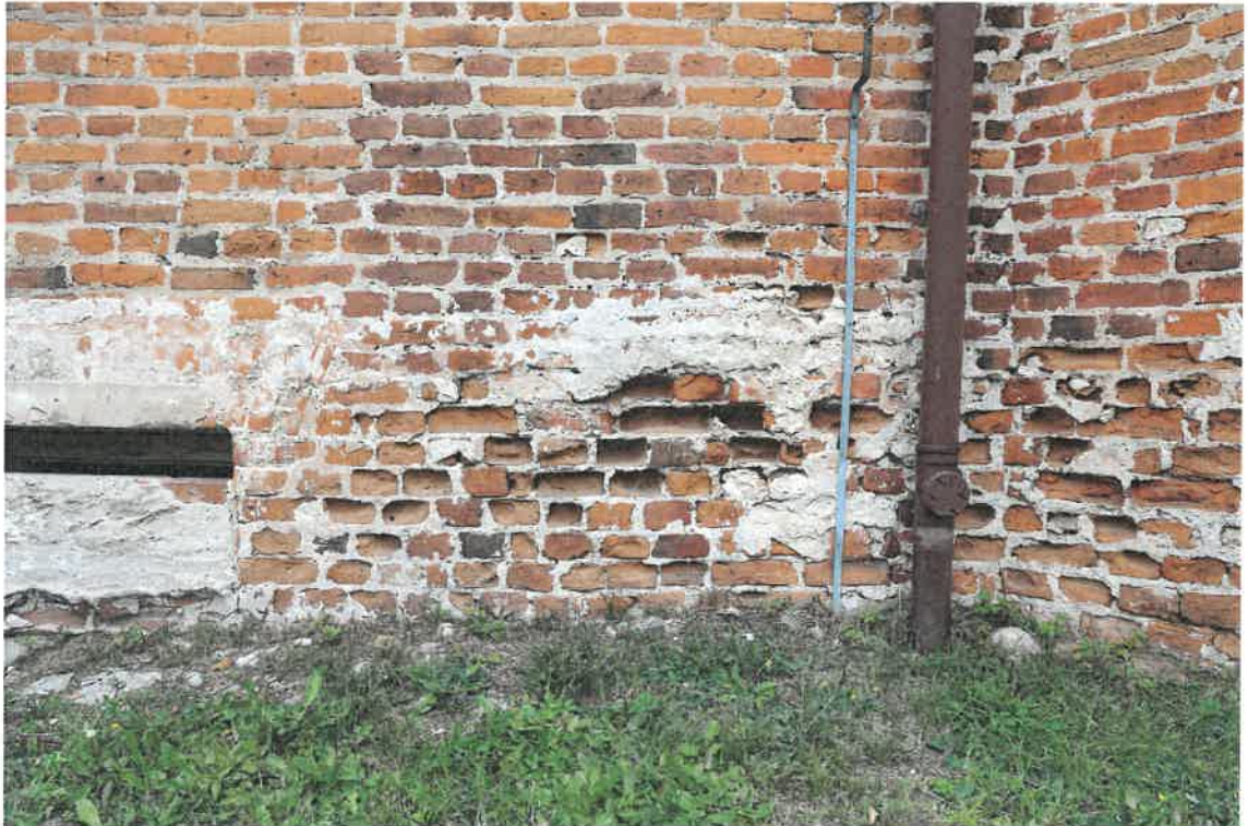
Skępe, kościół p.w. Zwiastowania NMP, elewacja południowa, partia cokołu.
