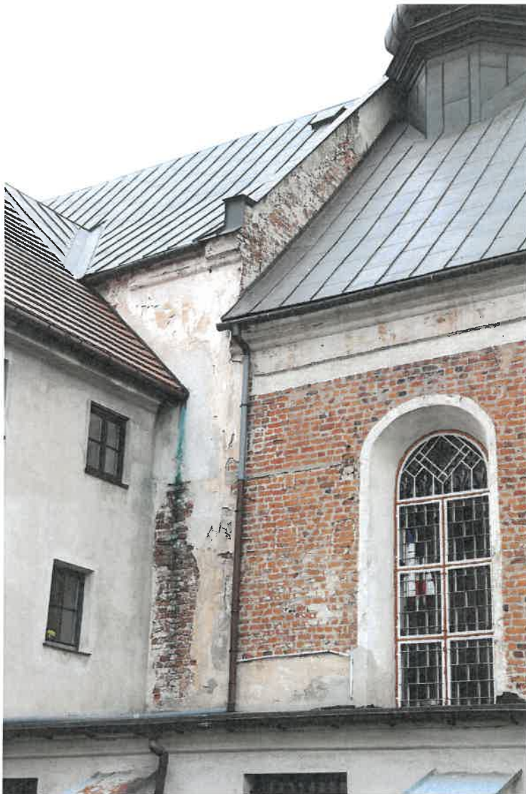
Skępe, kościół p.w. Zwiastowania NMP, elewacja południowa, styk nawy z prezbiterium.
