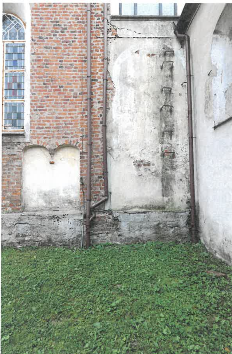
Skępe, kościół p.w. Zwiastowania NMP, elewacja północna, styk nawy z prezbiterium.
