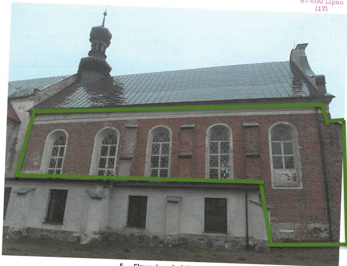
5. Elewacja południowa prezbiterium kościoła.
