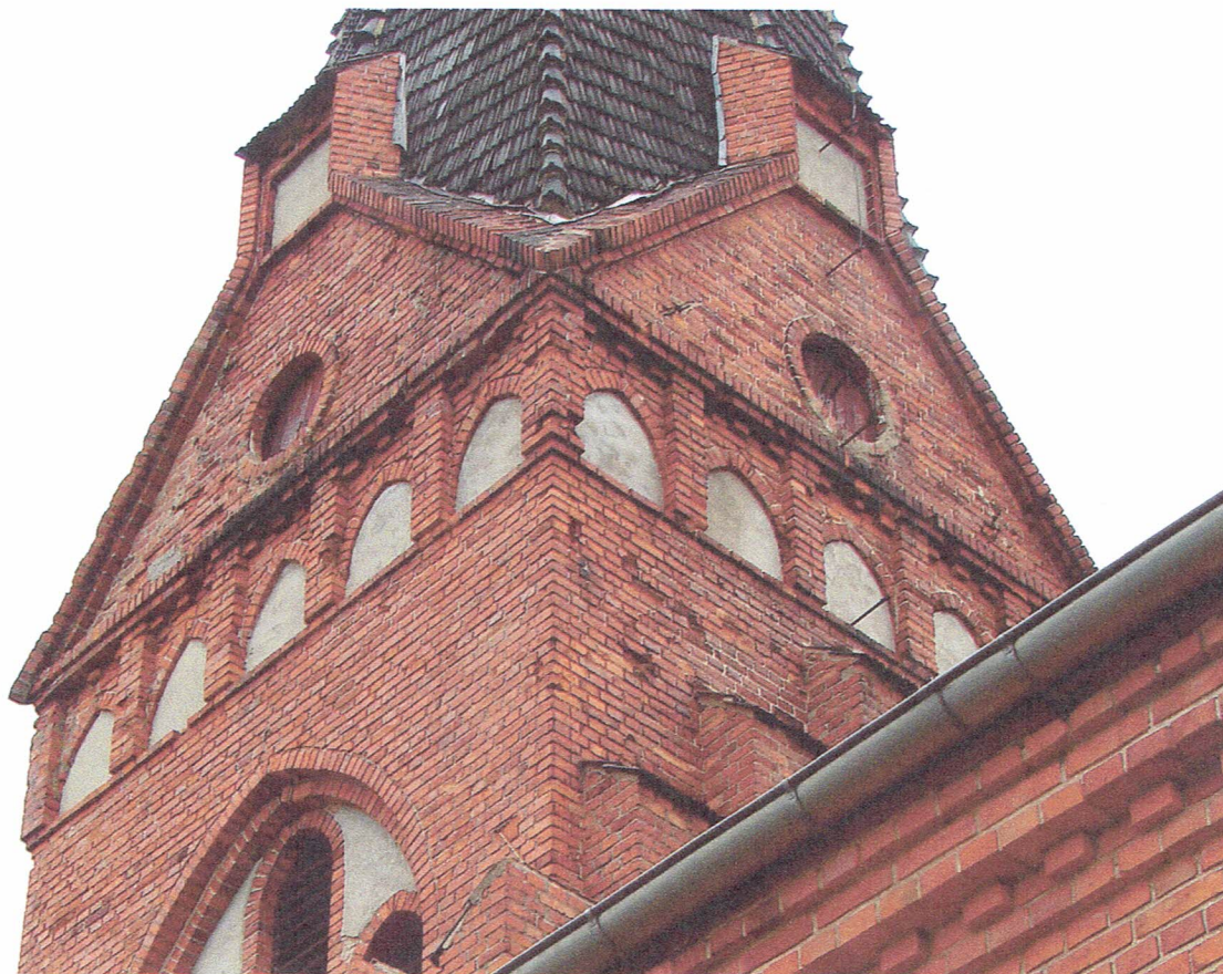
Fot. 4. Kościół parafialny w Złotorii, górna część wieży
