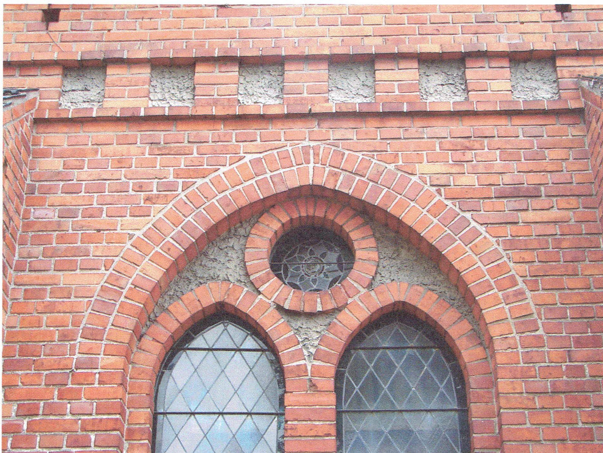
Fot. 3. Kościół parafialny w Złotorii, fragment elewacji bocznej – detal architektoniczny.
