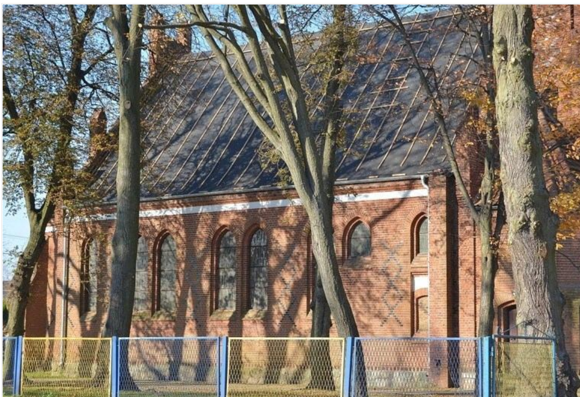
II. 2 Grzybno 59, Kościół p.w. Najświętszego Serca Pana Jezusa - widok na południową elewację kościoła oraz połąć dachu nad korpusem po pracach w 2021 r. fot. Ewa Bożejewicz 2022 r.
