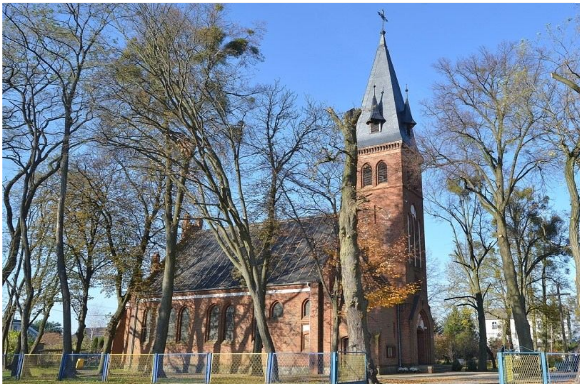
II. 1 Grzybno 59, Kościół p.w. Najświętszego Serca Pana Jezusa - widok na elewację południową kościoła po pracach ciesielskich i wstępnych dekarских w 2021 r. fot. Ewa Bożejewicz 20221
