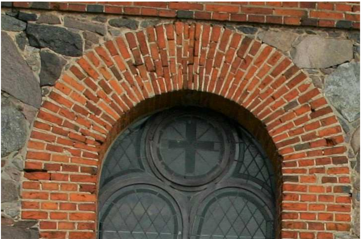
Fot.11. Lubiewo, kościół pw. św. Mikołaja, stan zachowania wątku ceglanego. Ubytki cegły mają w większości charakter mechaniczny i ograniczone są w większości do powierzchni materiału.
