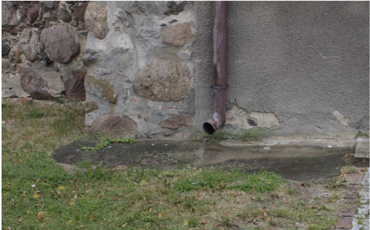
Fot.9. Lisewo, kościół pw. Podwyższenia Krzyża Świętego, elewacja południowa. Na zdjęciu widoczny sposób odprowadzenia wody z dachu kruchty południowej.
