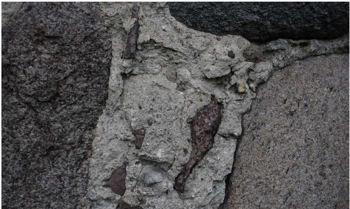
Fot.12. Lisewo, kościół pw. Podwyższenia Krzyża Świętego. Na zdjęciu widoczna tekstura zaprawy spoinującej wątek kamienny. Zaprawa posiada bardzo zróżnicowane frakcje kruszywa z odłamkami dochodzącymi do śr. 10mm.
