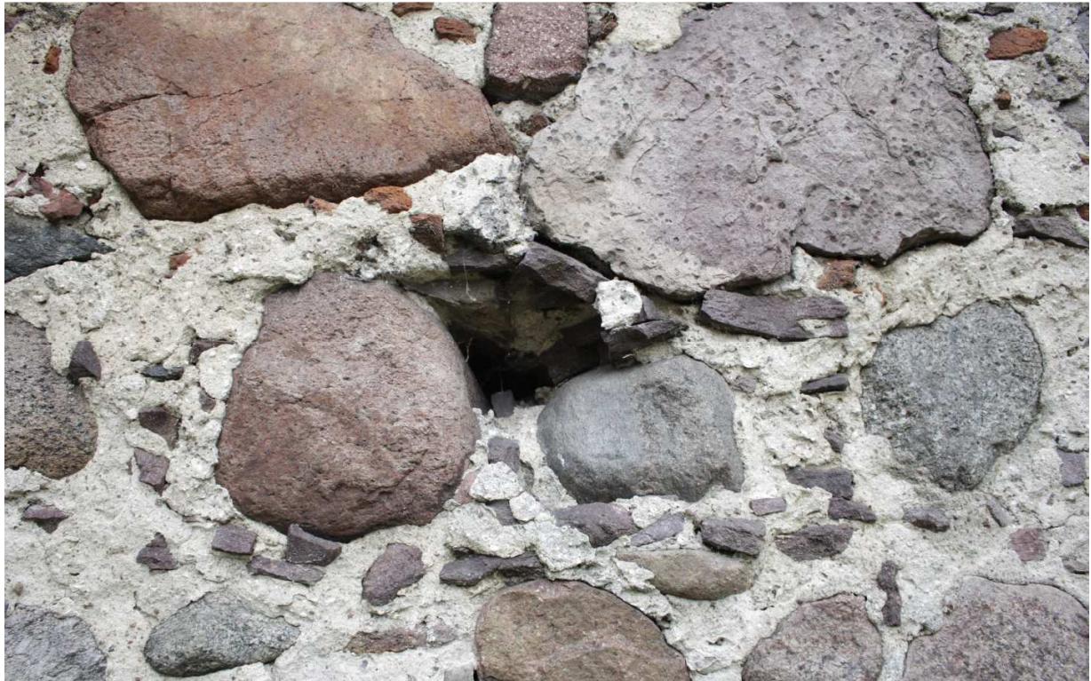
Fot.11. Lisewo, kościół pw. Podwyższenia Krzyża Świętego. Na zdjęciu wątek kamienny z zachowanym otworem maculcowym.
