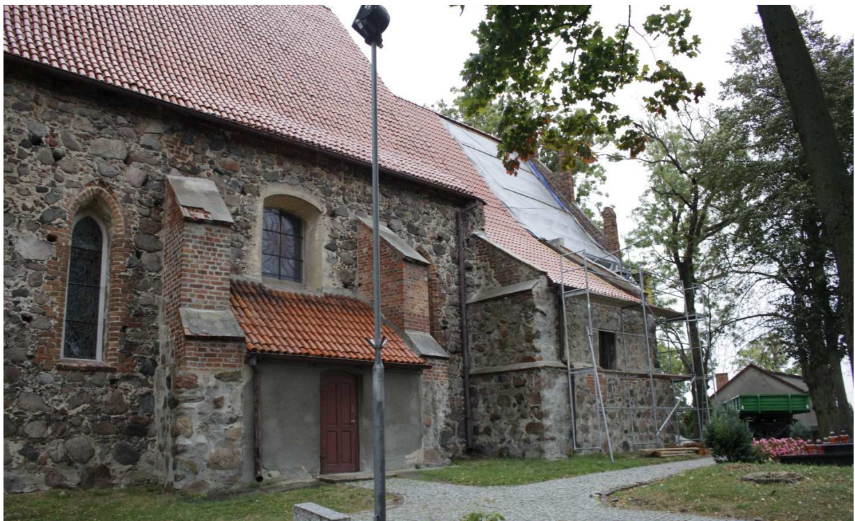
Fot.2. Lisewo, kościół pw. Podwyższenia Krzyża Świętego, widok ogólny na elewację południową.
