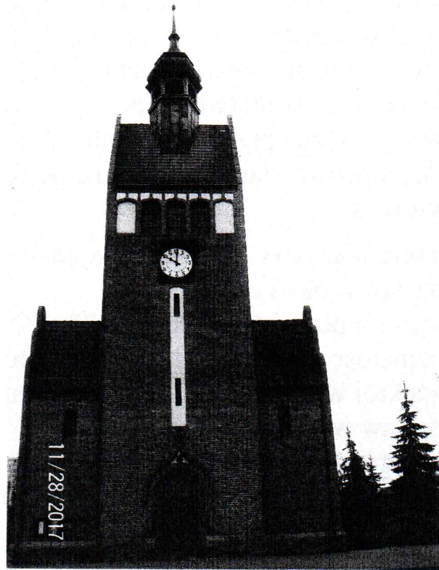
Fot.1. Elewacja północna.
