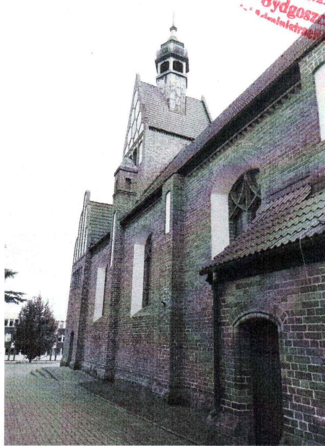
Zdj. 2- Elewacja zachodnia – widok ogólny.
